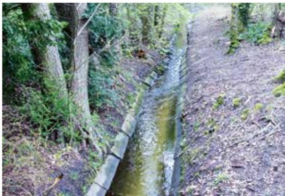
Um das Wasser des Packereigrabens schnell abzuleiten, wurde der Graben mit Steinplatten versiegelt. Das unverbauter Umfeld zeigt: Hier ist mehr für die Natur möglich.
