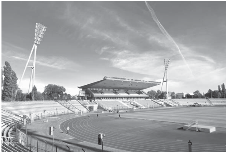
Das Cantian-Stadion im Jahn Sportpark, erbaut 1951, soll abgerissen werden.
