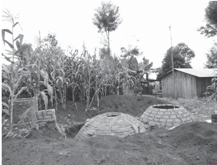
Eine Biogasanlage für eine Familie in Kenia im Bau
