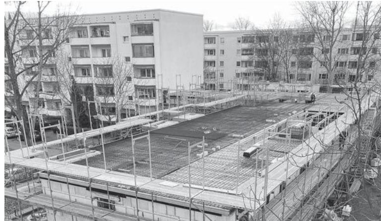
Der grüne Innenhof in der Atzpodienstraße in Lichtenberg wurde zerstört.
